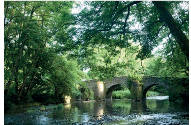
Brücke bei der Klosteranlage Marienstatt
