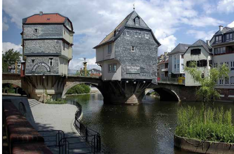
Alte Nahebrücke in Bad Kreuznach
